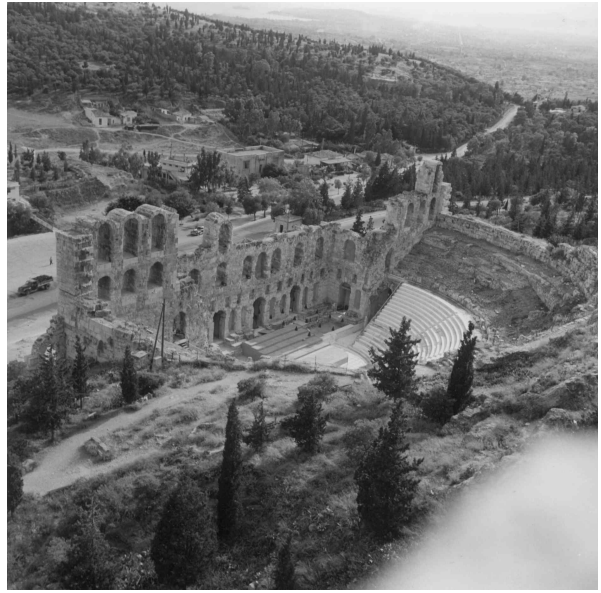
Abb. 98: Odeion des Herodes Attikus. Gesamtansicht des Bühnenhauses und der Treppenhäuser von Nordosten (DAI Athen, Bauten 71)
