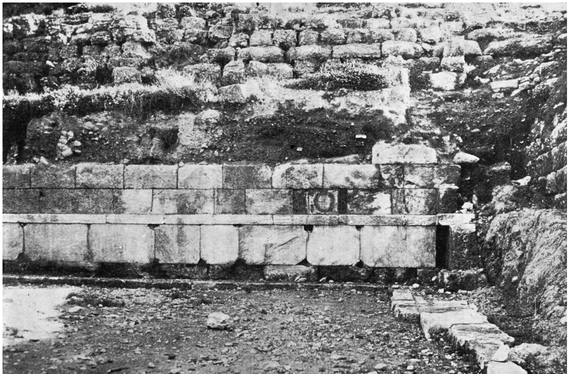
Abb. 28: Ansicht des NW Abschnittes der Nordmauer des Odeion des Perikles von S (A. Orlandos, Prakt 1931 Abb. 1)
